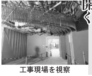
工事現場を視察
